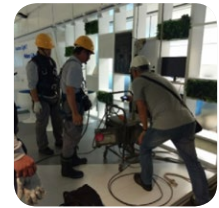
承攬商機械、設備檢查
