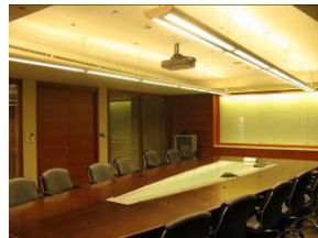
光寶科技內湖總部會議室安裝照片
