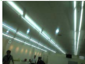
日本通訊行安裝照片
